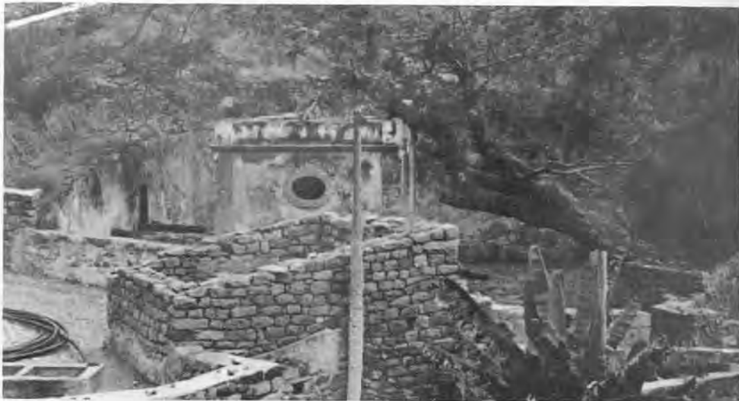
Fig. 111 — Nascente de Vinagre, Brava
