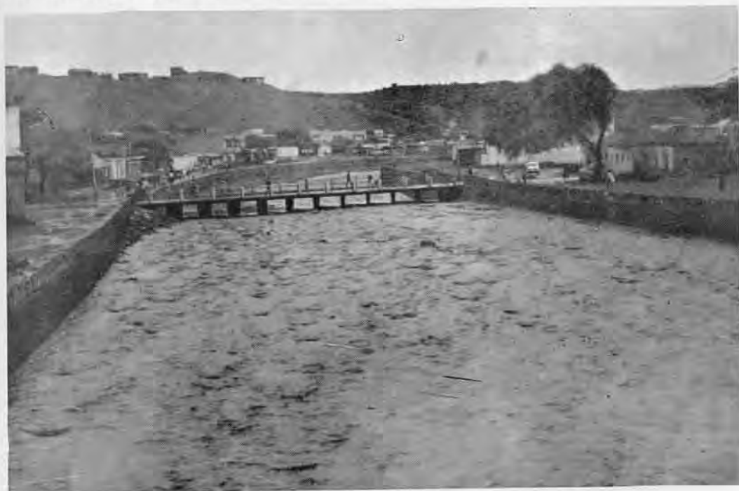
Fig. 84 — Cheia resultante de chuva torrencial
