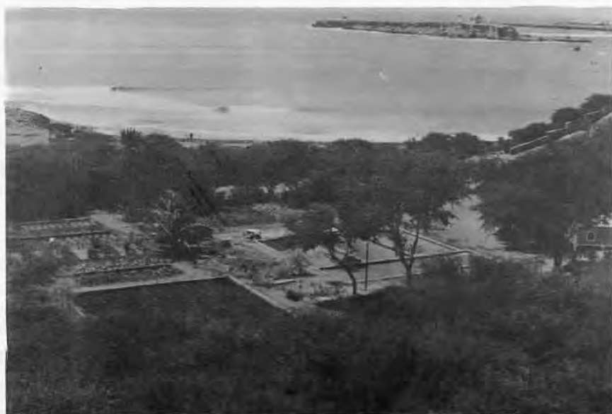
Fig. 95 — Estação de tratamento das águas dos esgotos
