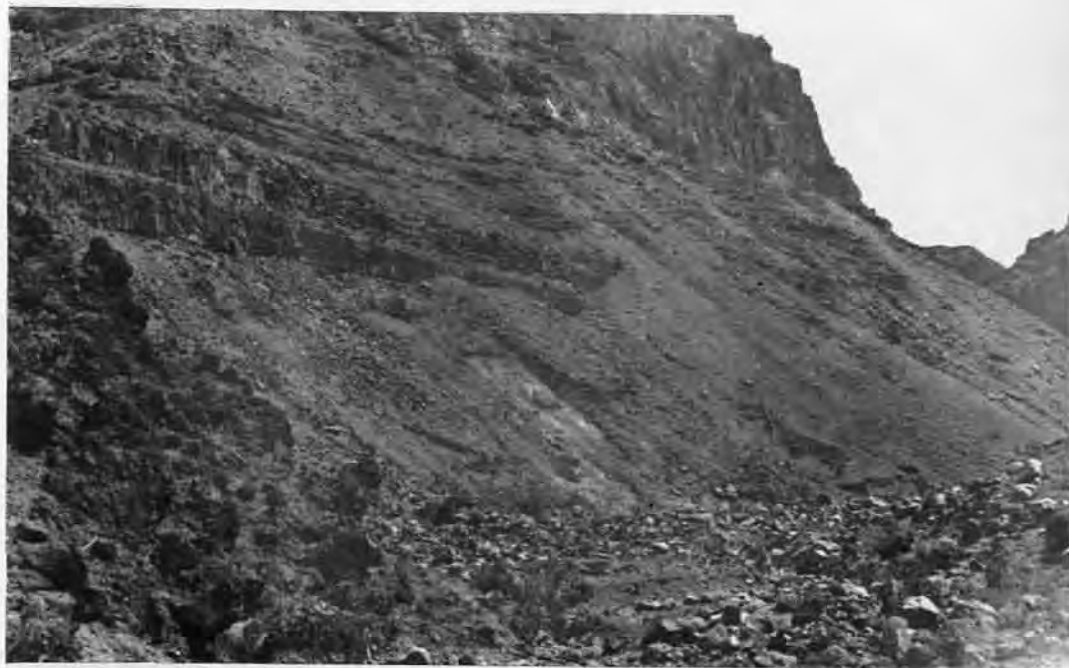
Fig. 32 — Queda de blocos da cornija no vale de Porto Mosquito
