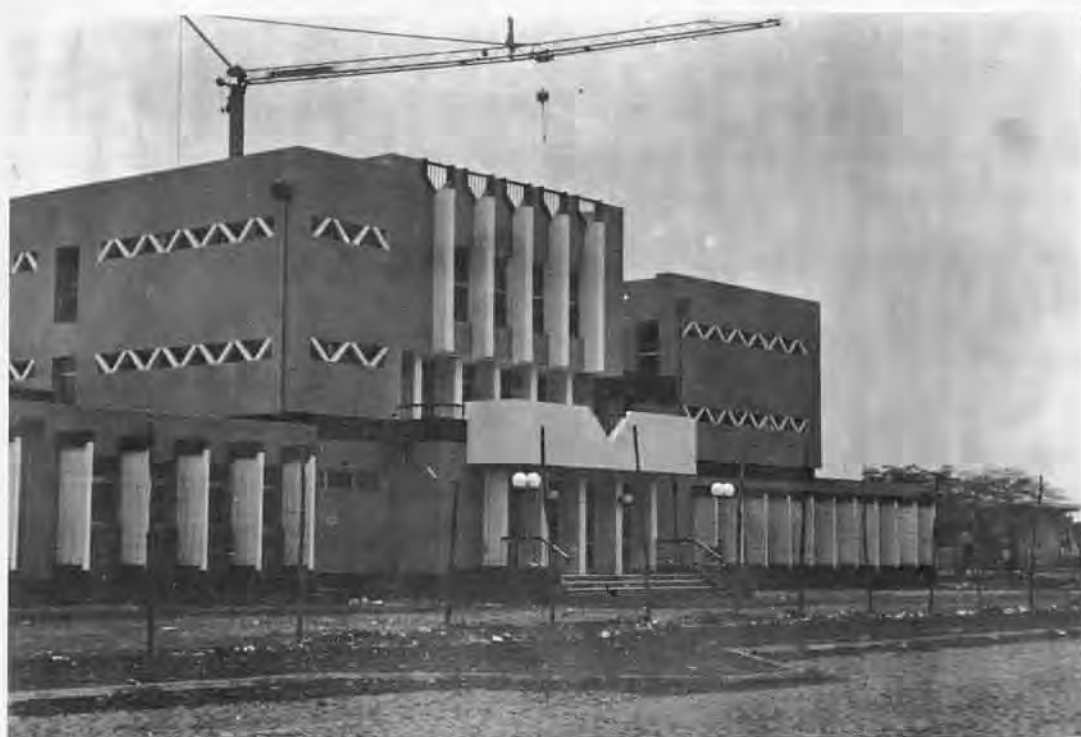
Fig. 153 — Novas instalações do Instituto Pedagógico, na Praia, Santiago
