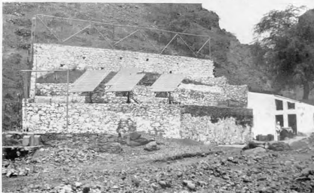
Fig. 100 — Utilização da energia fotovoltaica na extracção de água de um poço, em Santiago
