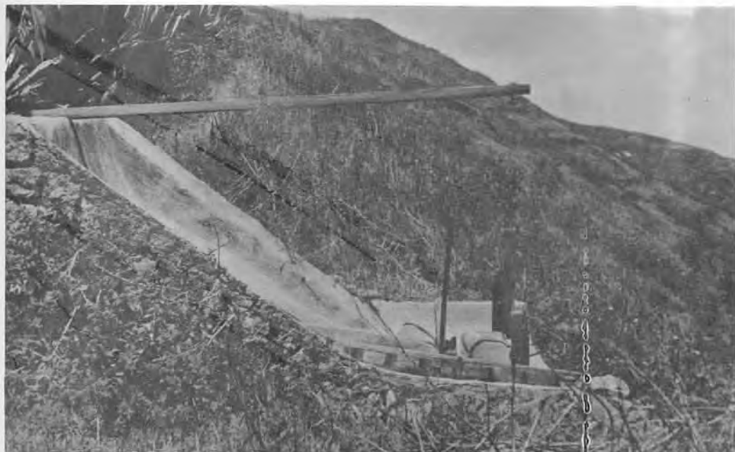
Fig. 94 — Dispositivo de captação de nevoeiro
